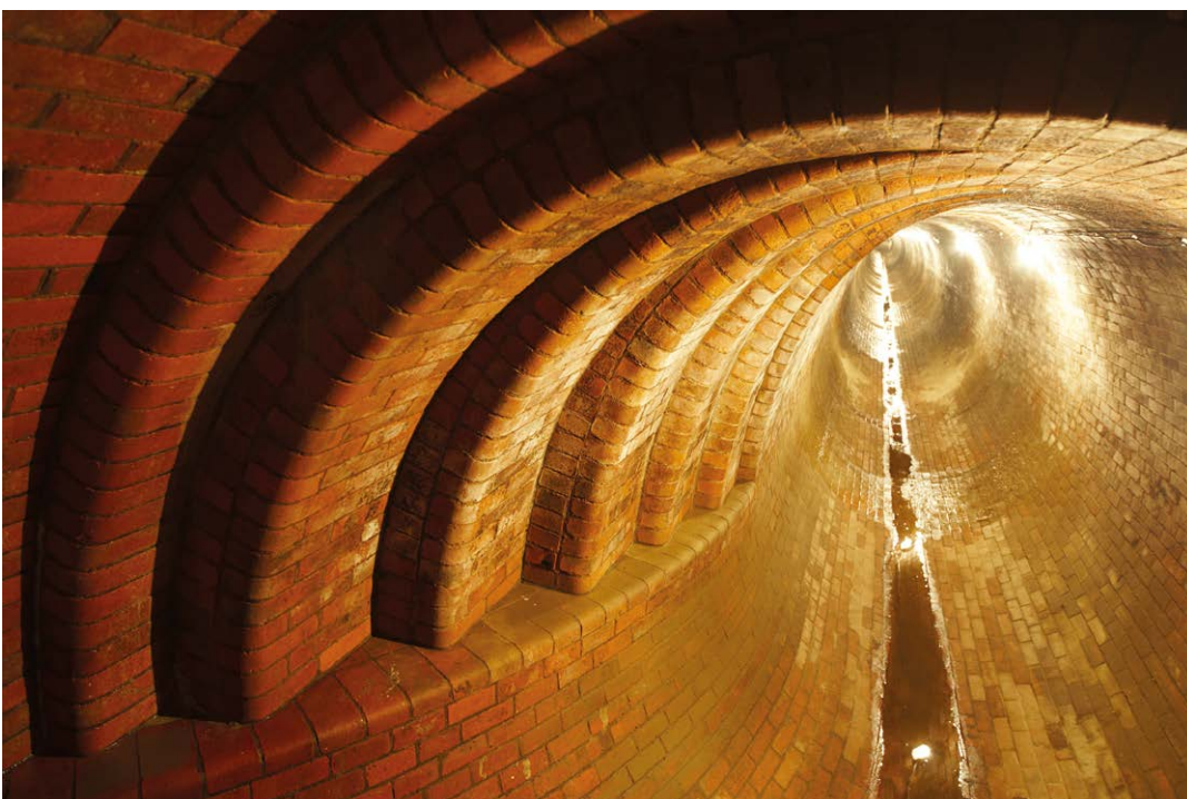
Die Kontrolle von Abwässerkanälen ist eine wichtige Aufgabe im Kanalmanagement (Quelle: © chalabala – Fotolia.com)
